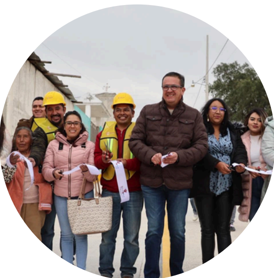
Barrio Casas Coloradas se realizó la entrega de 989.00 m 2 de pavimentación hidráulica y 22.90 m de drenaje sanitario en la calle 7 de Julio.
